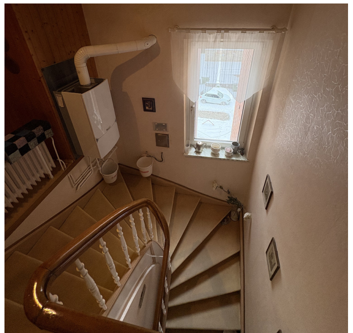
Treppe 2. OG → DG
