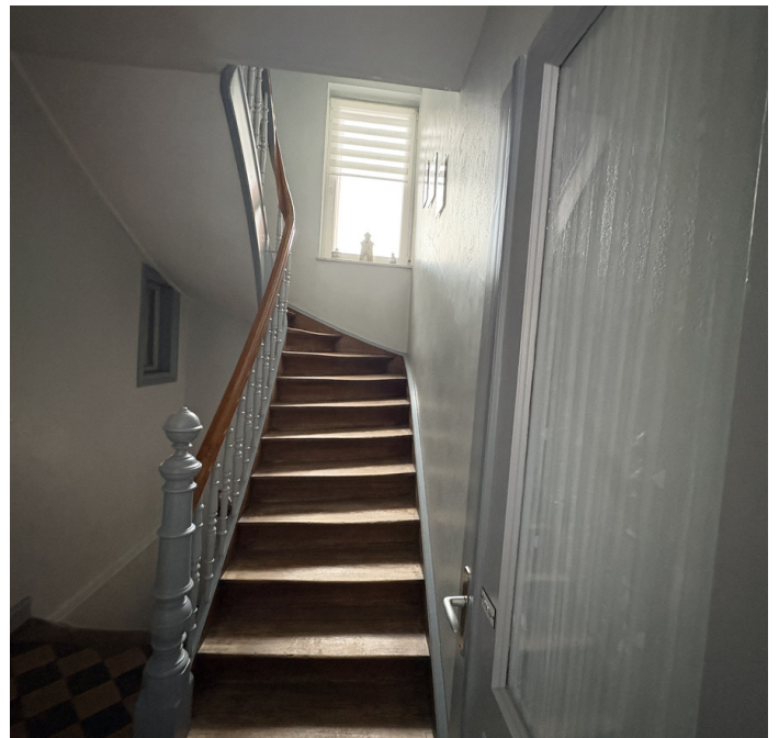
Treppenaufgang EG → OG
